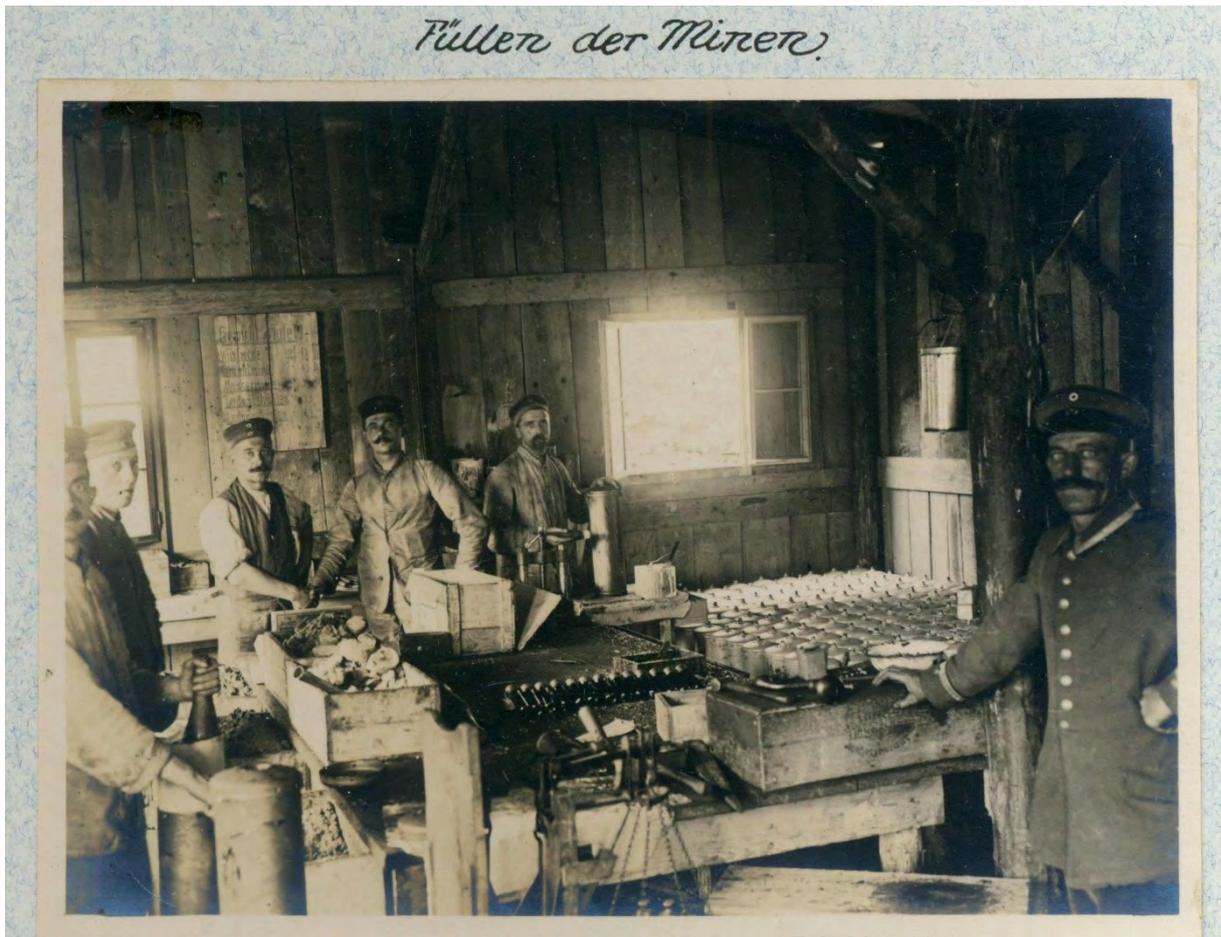
**Abb. 30** „Foto vom Füllen der Minen in der Nahkampfmittelfabrik Efringen“. Das Füllen erfolgt in Handarbeit; bei den vorne links und hinten rechts zu sehenden Wurfminen handelt es sich mutmaßlich um Geschosse der Art, die der Autor in den Vogesen am Sudelkopf und am Hilsenfirst in situ gesehen hat (LA BW, Abt. GLA Karlsruhe 456 F 105 Nr. 154 Foto 9: <http://www.landesarchiv-bw.de/plink/?f=4-1700141-1>).
